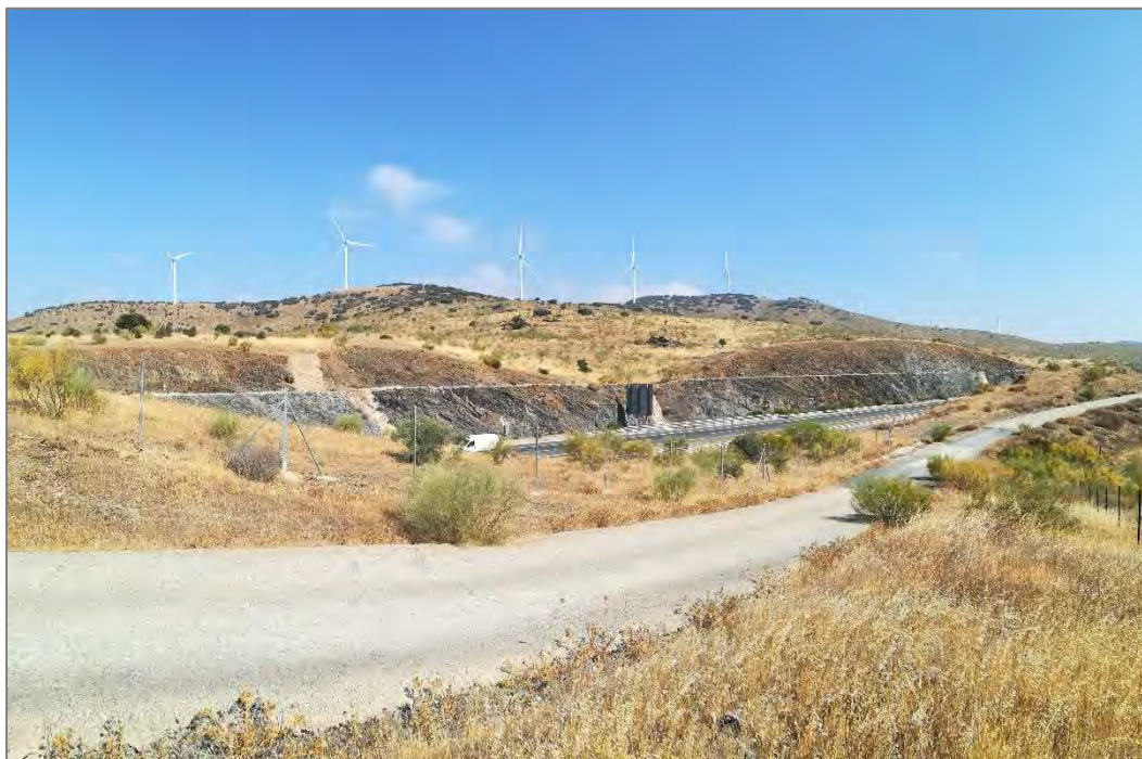
Fotografía 4. Caminos de acceso a las parcelas de implantación del proyecto y parque eólico al fondo.
