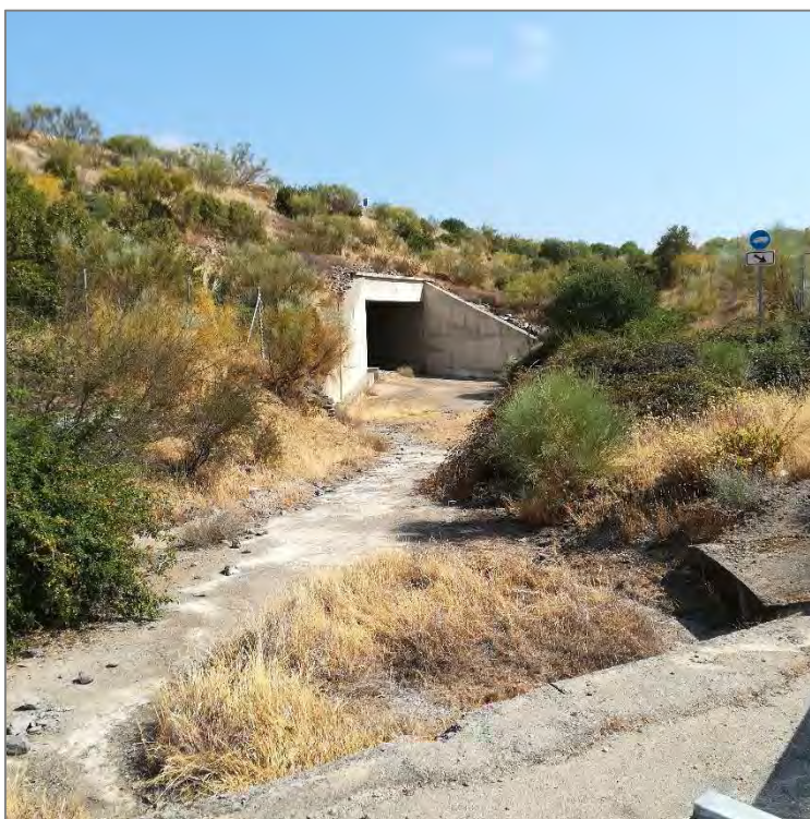
Fotografía 7. Paso de agua por debajo de la carretera existente en zonas cercanas a la implantación de la planta
